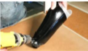
3. Utilizzare una punta da trapano da 1/8" per il foro pilota. Avere un inserto flessibile nella presa durante la perforazione del foro pilota.
